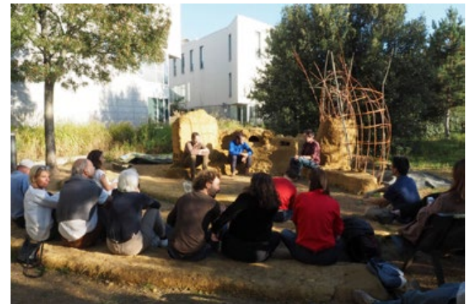
LA TERRE EMBRASSE LE SOL, 2019 VUE DU CHANTIER ET DES DISCUSSIONS
